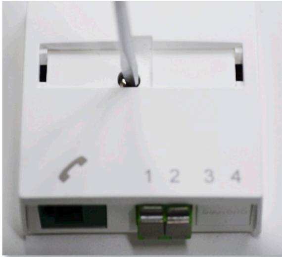
Bei dieser Dose kann die Abdeckung bis zum Grundrahmen entfernt werden. Dabei ist zu beachten, dass zuerst die Socket-ID Nr. mittels eines Schraubenziehers entfernt wird. Diese Nummer muss unbedingt aufbewahrt werden. Achtung: Die OTO-ID ist eindeutig pro Wohnung zugeordnet und darf nicht mit anderen Wohnungen vertauscht werden. Anschliessend die Schraube lösen und Dosenabdeckung entfernen. Die silbernen Staubschutzkappen müssen eingeklappt werden.
